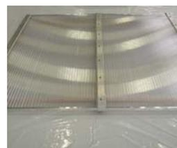
Vor dem Auflegen der Platten wird die Schutzfolie an den Längsseiten etwas gelöst.
