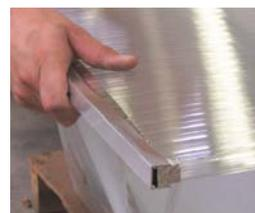
Die untere Stirnseite wird mit dem Aluminium-Tropfkantenprofil verschlossen. Bei Bedarf kann die untere Stirnseite vorher noch zusätzlich mit einem atmungsaktiven „Anti-Dust“-Klebeband abgeklebt werden. Dies kann ggfs. das Eindringen von Staub in die Kammern verhindern, jedoch in Einzelfällen zu erhöhter Kondenswasserbildung in den Kammern führen!
